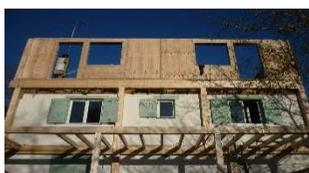
Le système constructif Module 3D permet de réaliser toutes les formes et superficies de maisons évolutives à ossature bois grâce à l'assemblage de **modules préfabriqués en bois** que l'utilisateur a choisi dans un catalogue selon son projet.
