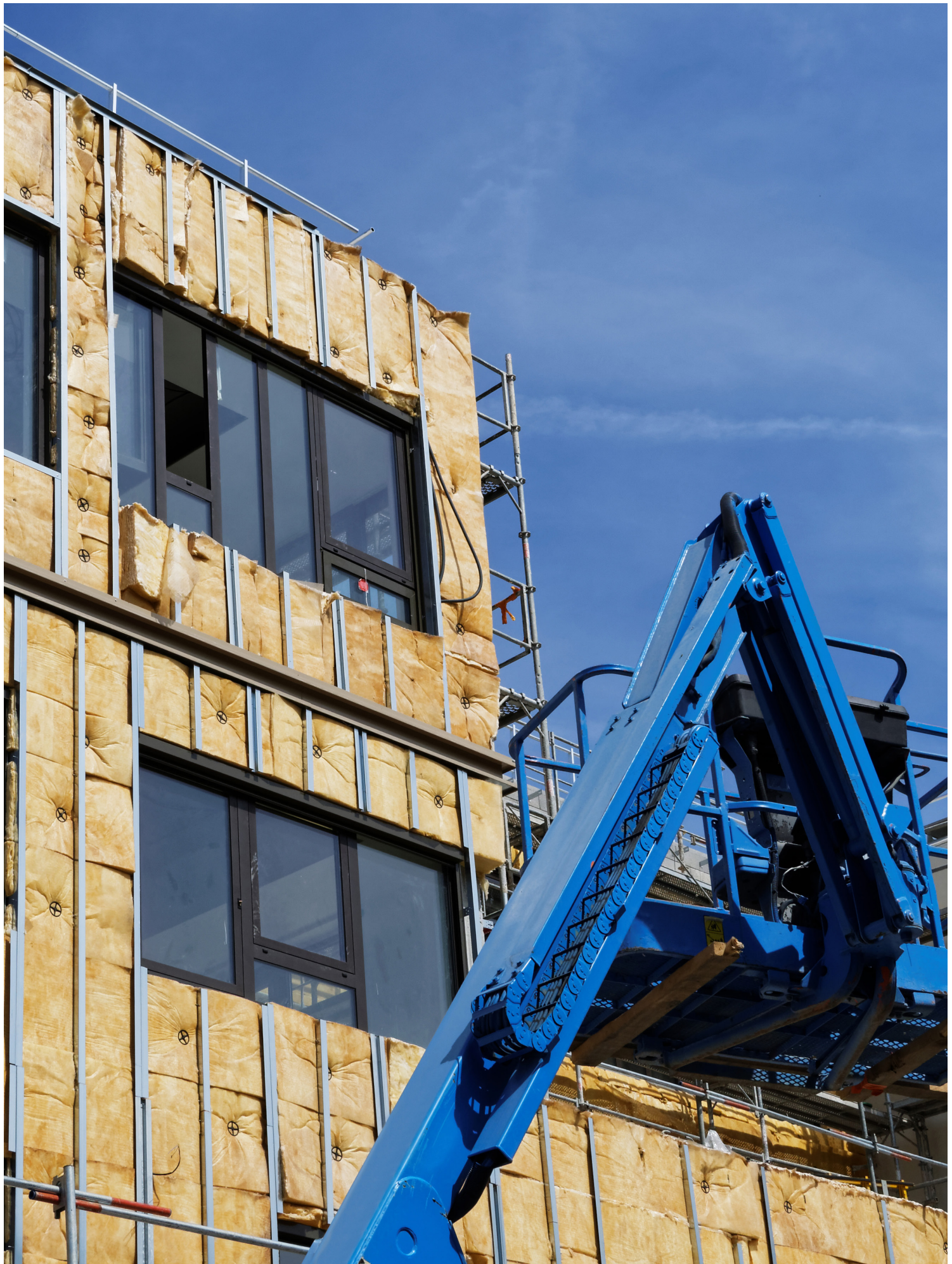
Bâtiment avec isolation chanvre
